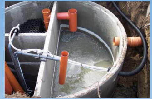
Vorklärung mit angeschlossenem Zulauf und Schlauchdurchführungen
