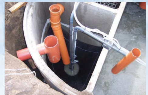
Nachklärung mit eingebautem PE-Trichter und Ejektoren zur Schlammrückführung in die Vorklärung sowie in die Belebung
